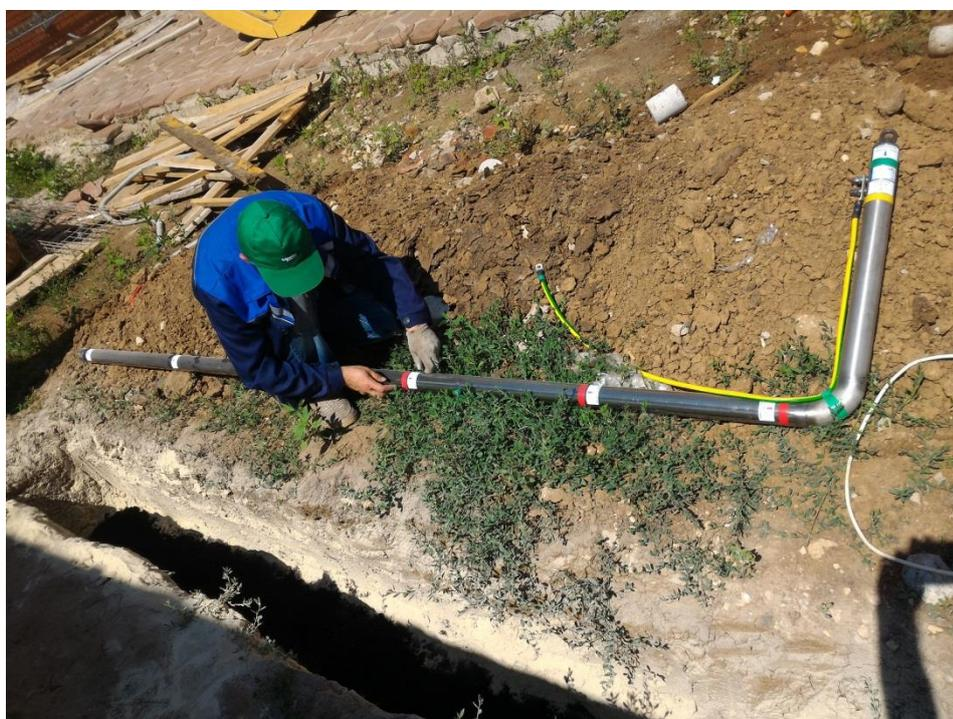
**Рисунок 1.** Монтаж горизонтального электролитического заземлителя АО «Хакель Рос»
