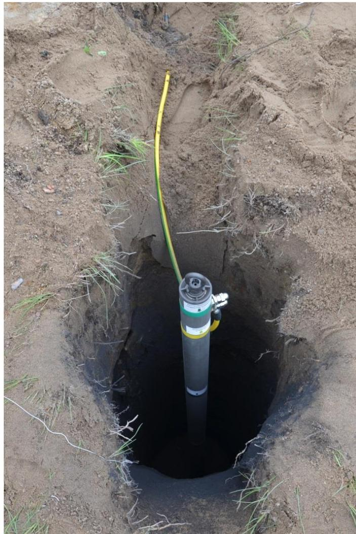
**Рисунок 2.** Монтаж вертикального электролитического заземлителя АО «Хакель Рос»
