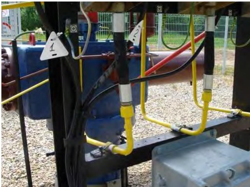
Рисунок 4. Крепление трубной обвязки подручными средствами.
