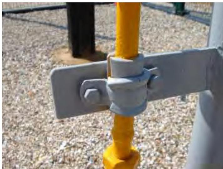
Рисунок 2 - Крепление трубной обвязки подручными средствами.
