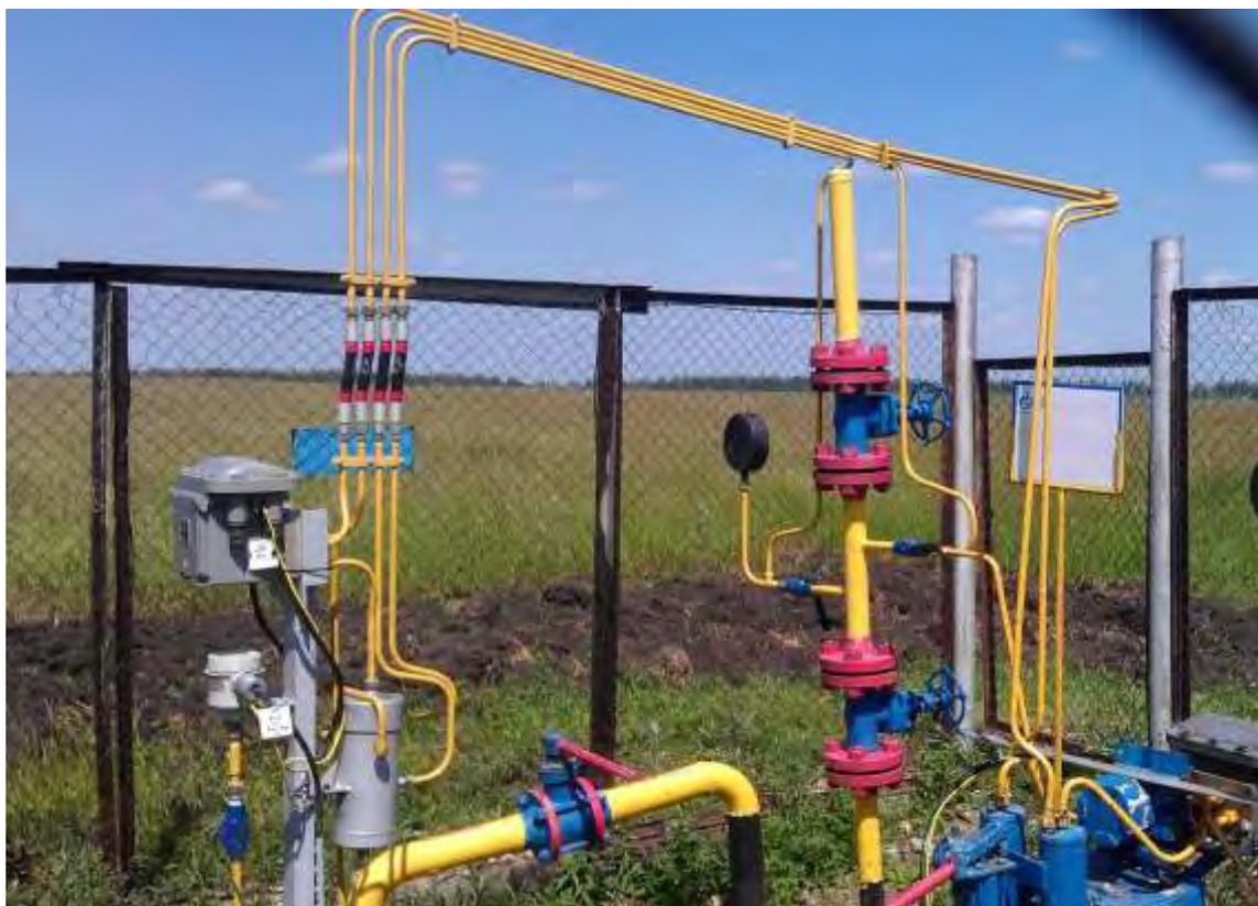
Рисунок 5. Отсутствие крепления трубной обвязки к металлоконструкциям.
