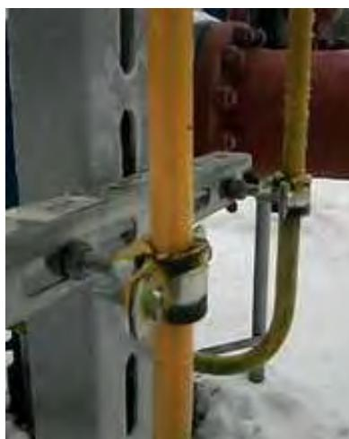
Рисунок 3 - Крепление трубной обвязки подручными средствами.
